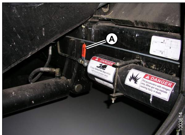
Рисунок 3.622: Выключатель гидроаккумулятора комбайна
