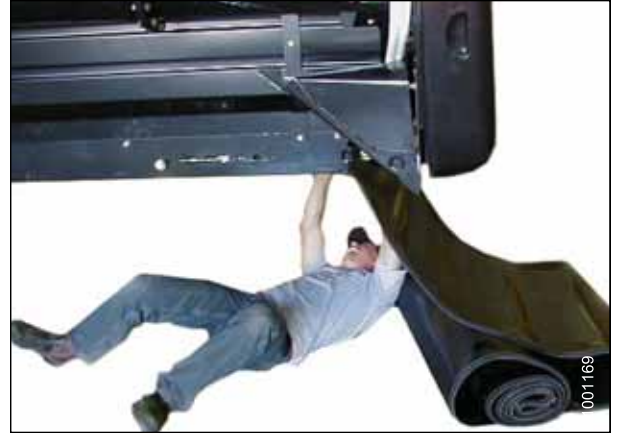
Figura 5.169: Instalação das esteiras
